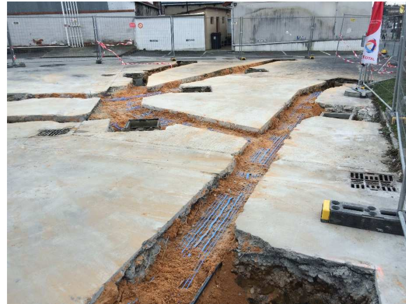
Tranchée pour le passage des réseaux
